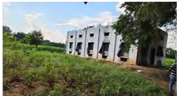
चित्र 4: प्लास्टिक शीट से ढकी गई खिड़कियां और वेंटिलेशन
